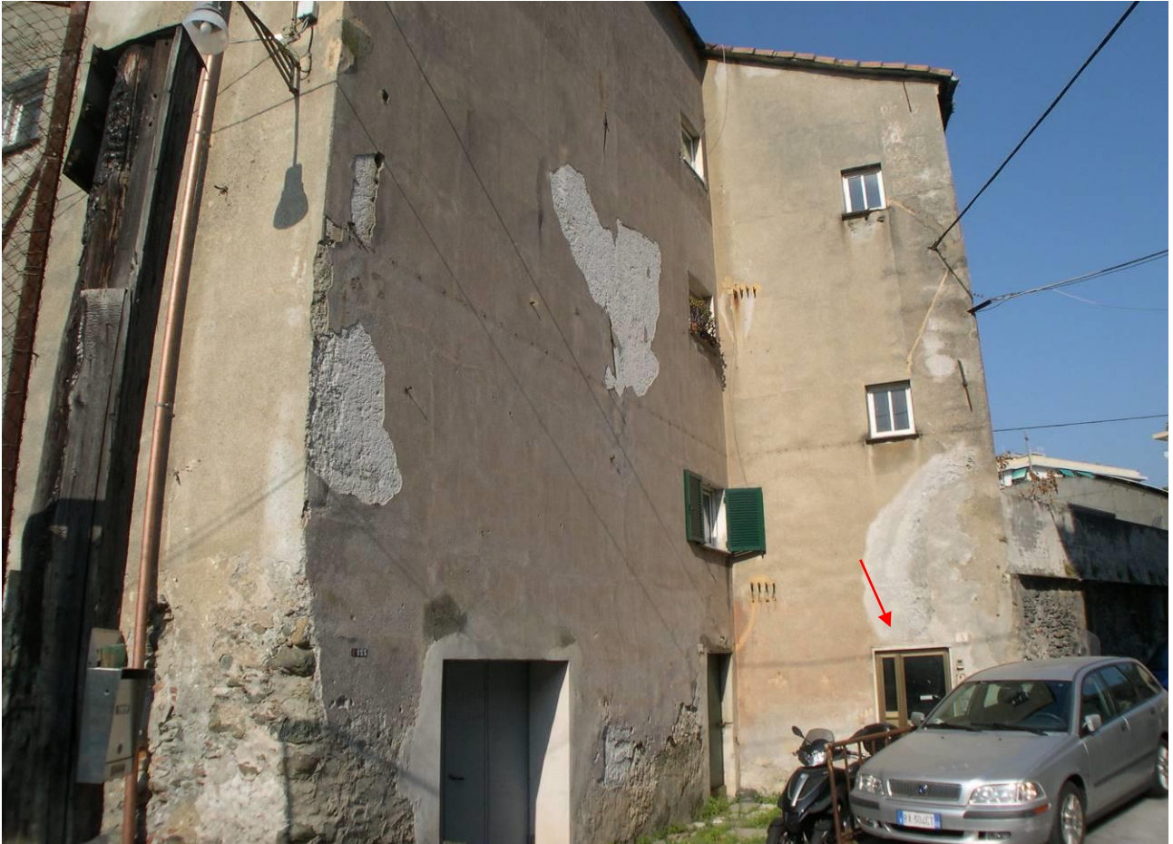
Foto 9 – Porta di ingresso da strada su Via Cialli
