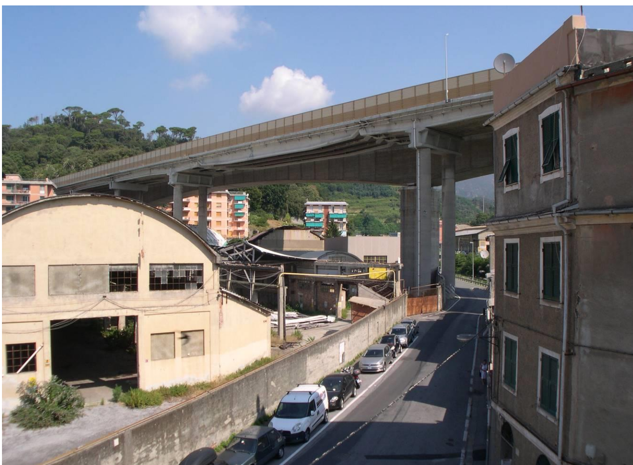
Foto 29 e 30 – Vista esterna dalla finestra della cucina
