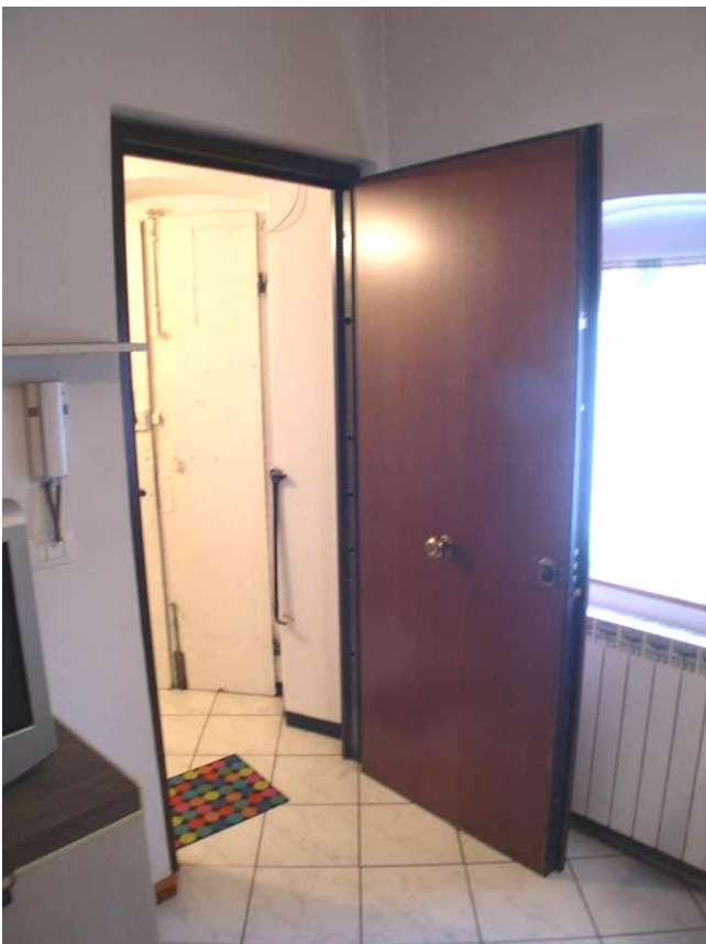
Foto 15 e 16 – Vista delle due porte blindate posizionate in corrispondenza del disimpegno di ingresso
